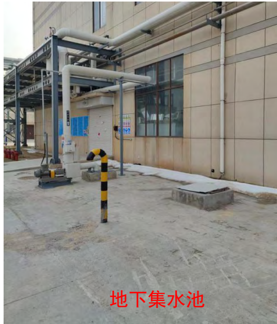
车间外集水池
