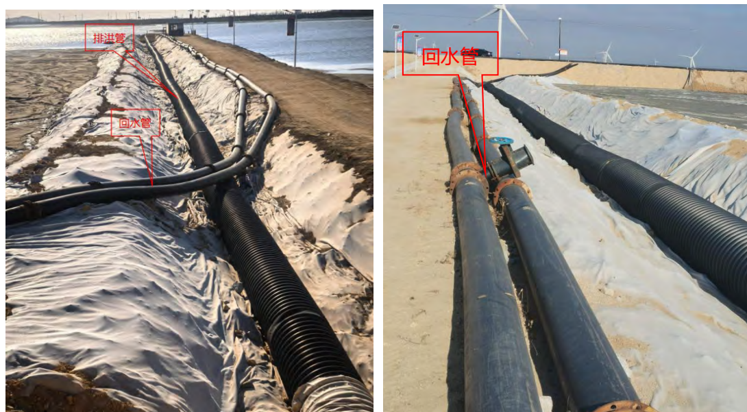
图 3.2-17 回水管线
