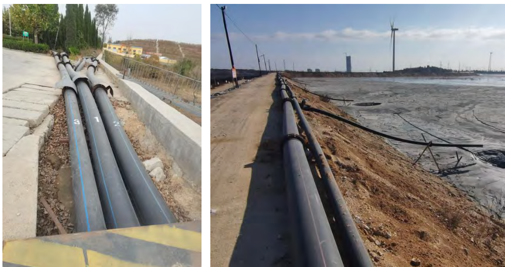
图 3.2-16 尾矿输送管线
