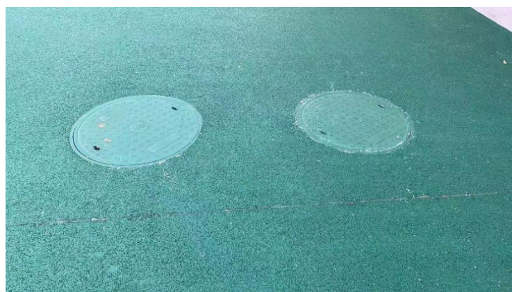
图 3-2 污水排放口照片
