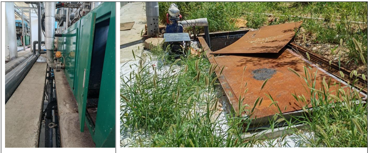
图 4.2-1 车间导流地槽及厂区事故水池
