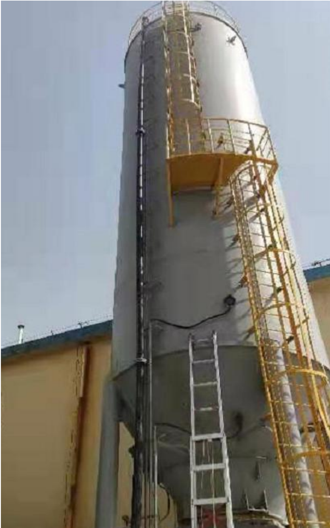
石灰仓及废气回收导管
