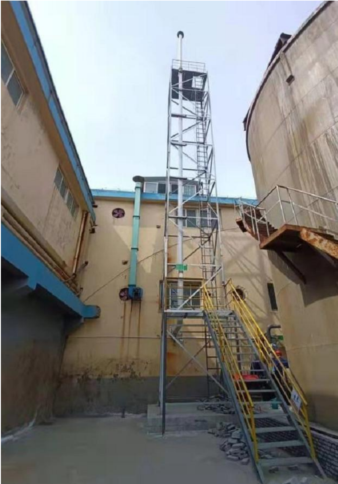
SART 系统废气排气筒
