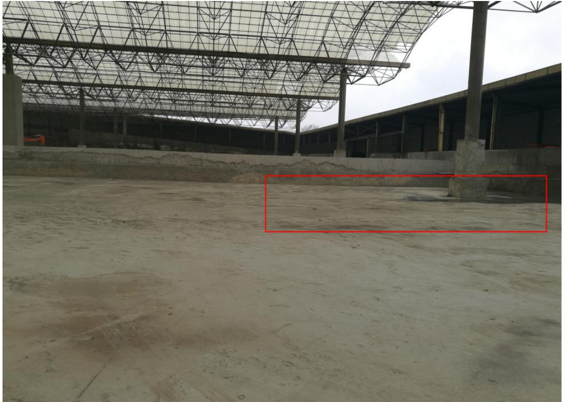
危废库锌泥暂存区
