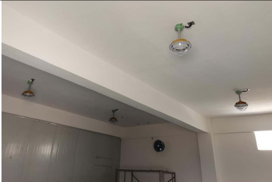
危险废物暂存间
