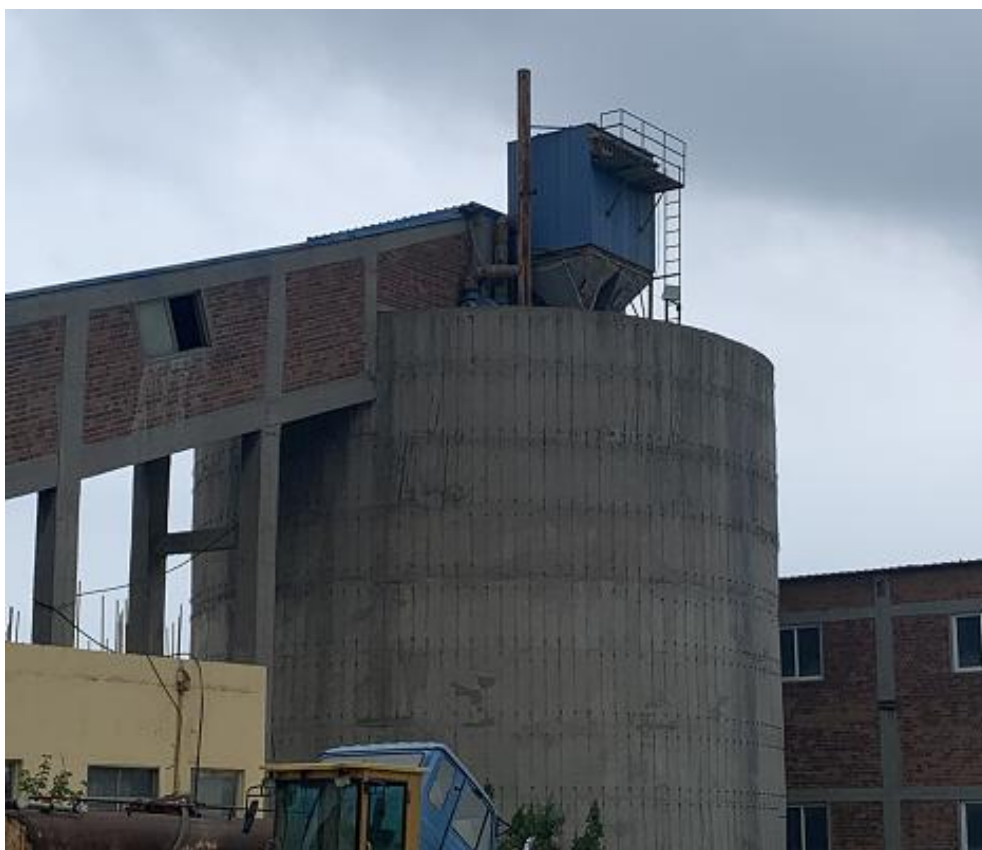
粉矿仓及废气处理
