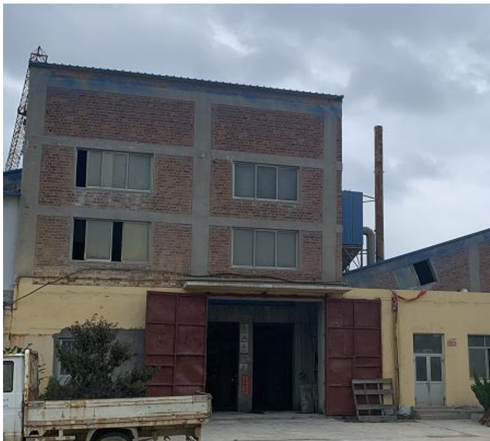
筛分车间及废气处理
