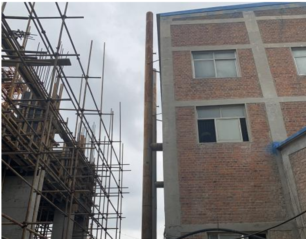
中碎细碎废气排气筒
