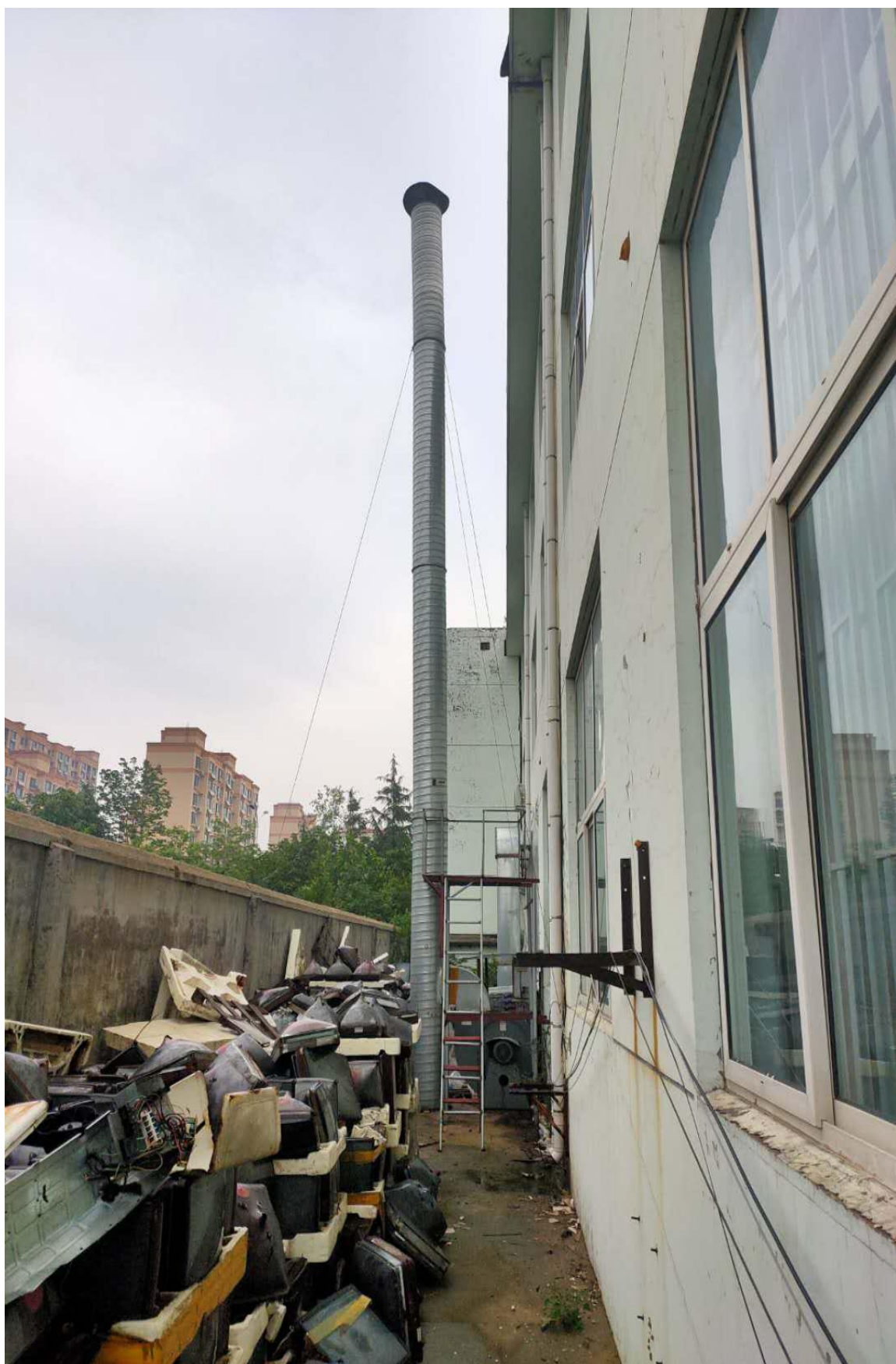
排气筒、取样平台
