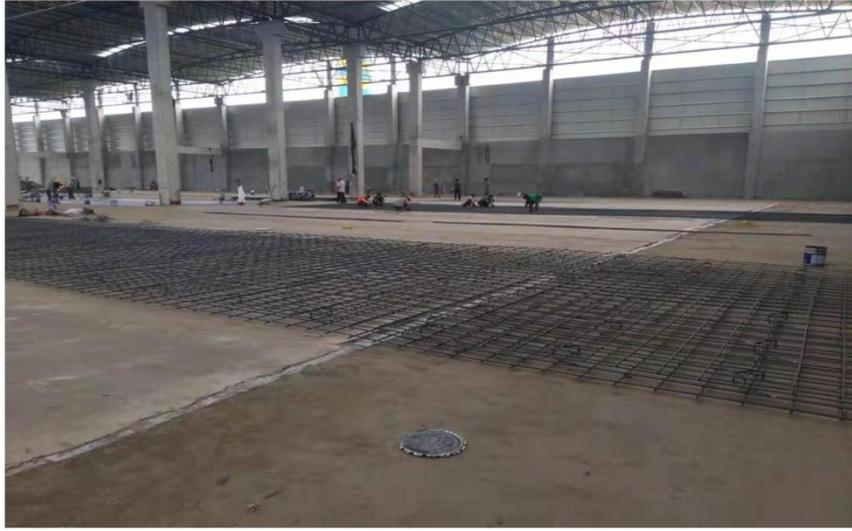
地面钢筋及防水层保护砂浆（拍摄时间20190827）
