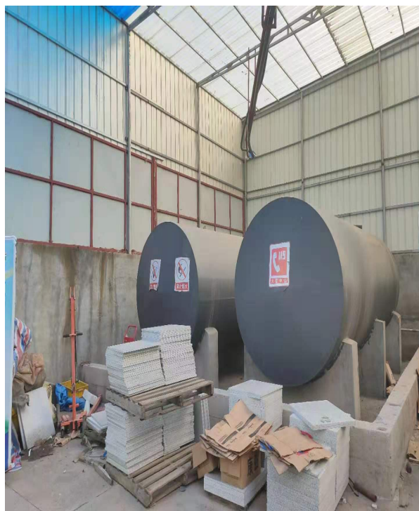
20m 3 醇基燃料储罐
