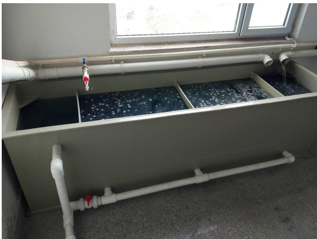
清洗废水中和池
