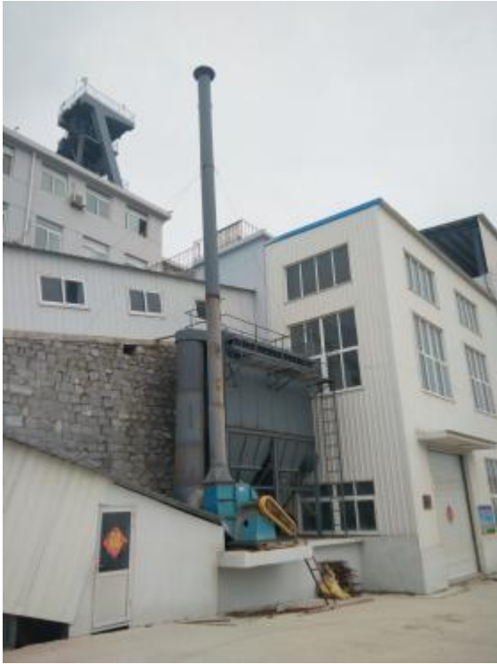
图 8-1 破碎除尘器
