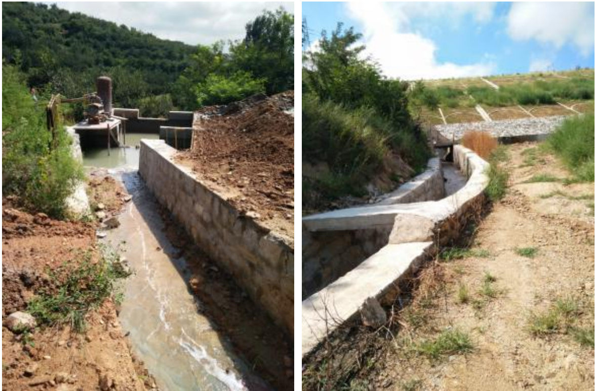
图 7-2 尾矿库回水池
