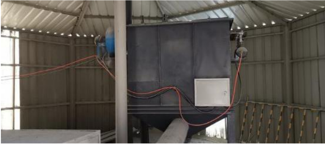
图 8-4 粉矿仓除尘器
