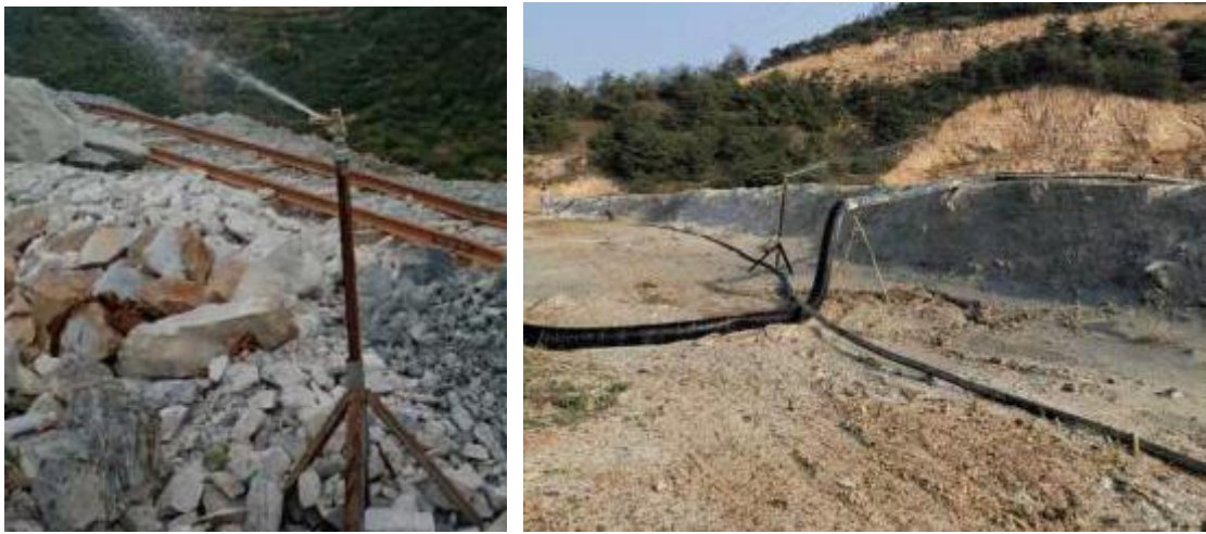
图 8-5 废石堆场及尾矿库喷淋设施
