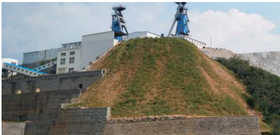
图 6-1 废石堆场绿化照片
