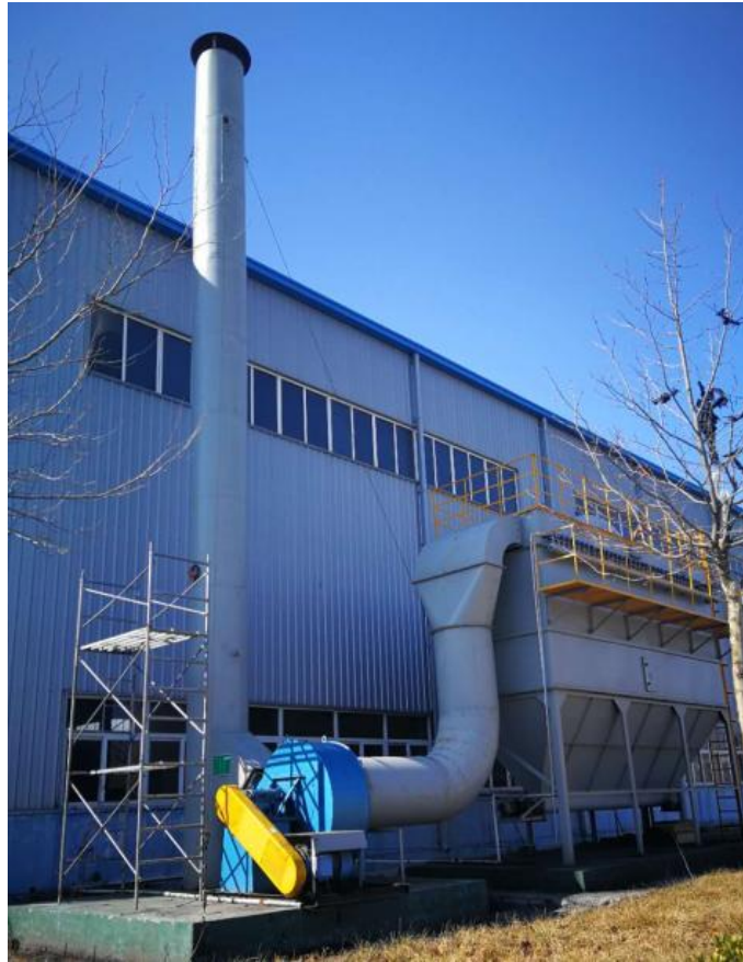
布袋除尘器+排气筒
