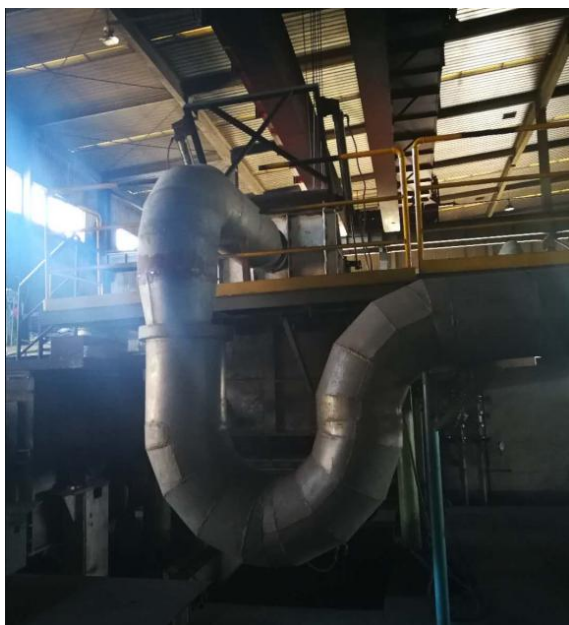
熔炼炉投料集气罩
