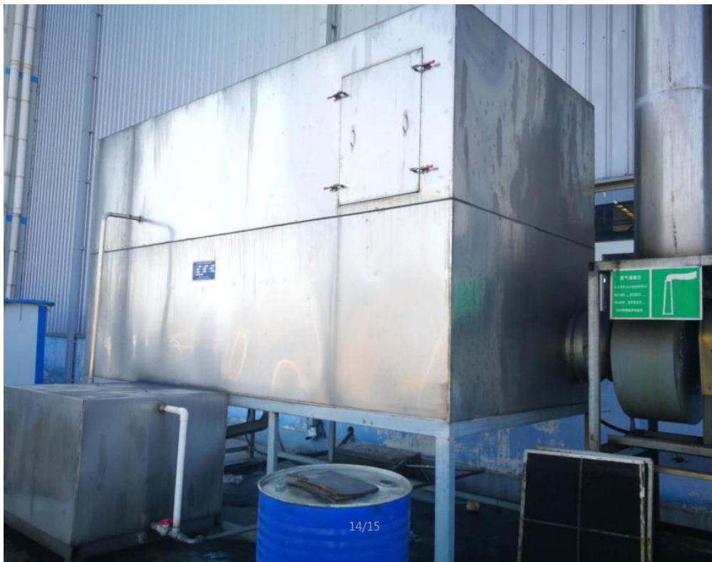
内螺纹成型废气处理装置
