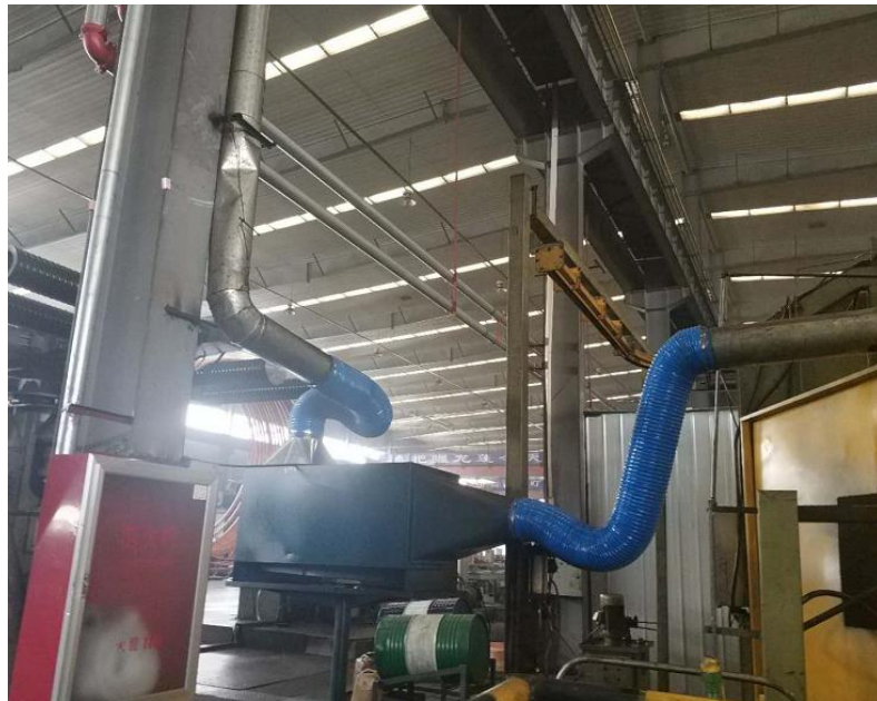
倒立式圆盘拉伸机废气处理装置+排气筒
