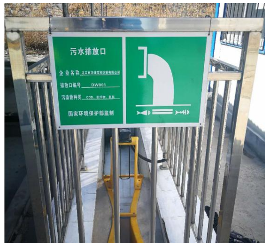
污水站排放口
