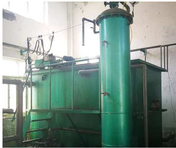
破乳气浮装置
