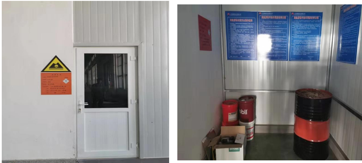
图 4-2 项目危废暂存间
