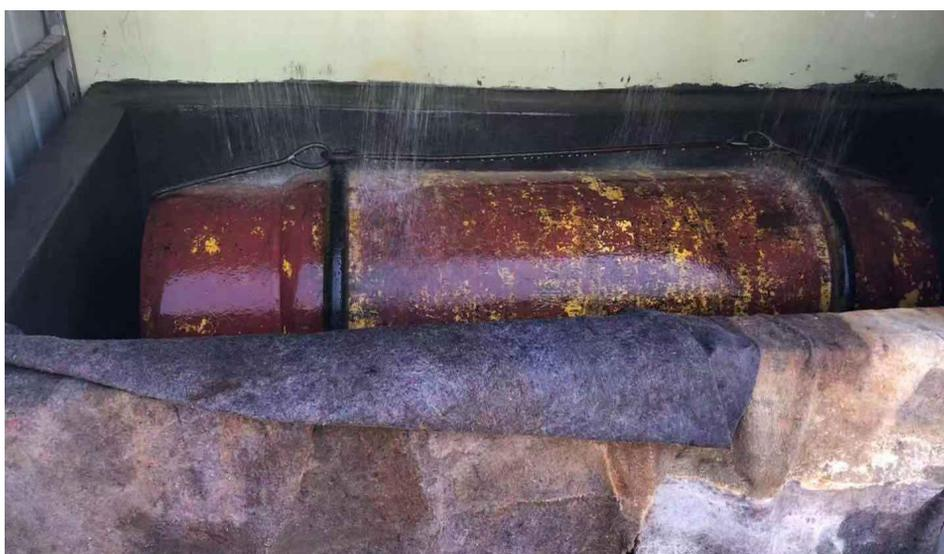
液氨罐区喷淋设施及围堰
