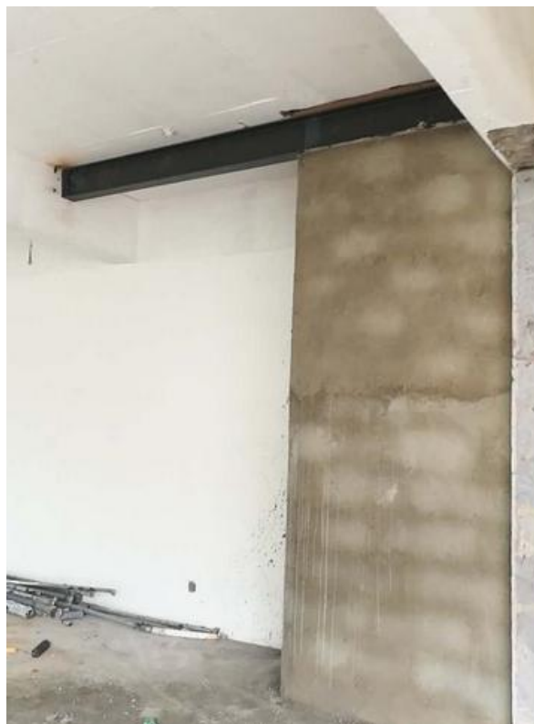
商建区油烟通道
