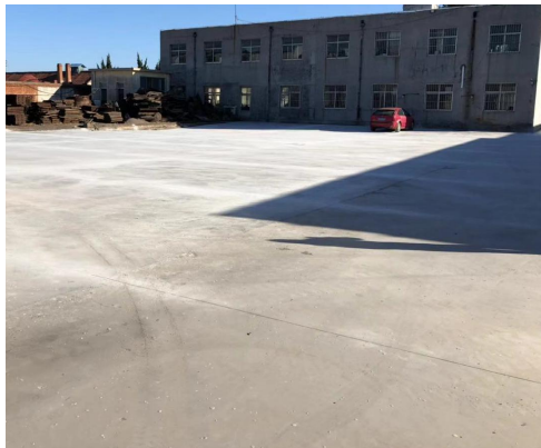
图 4-5 地面硬化情况
