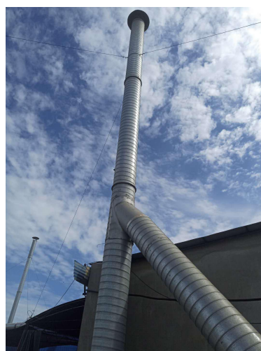
图 3-7 除尘 15m 排气筒
