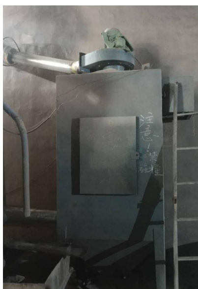
图 3-8 抛丸机除尘器
