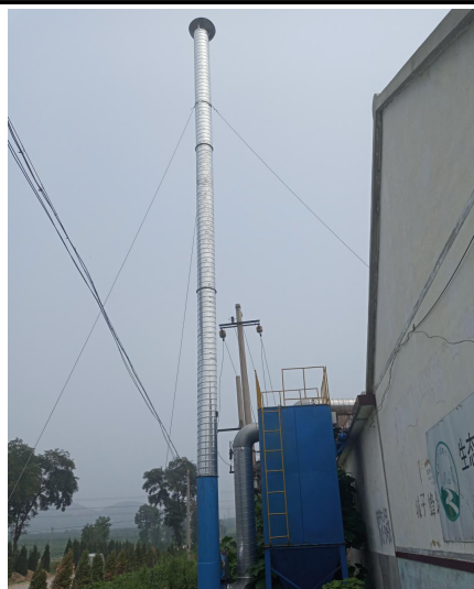
图 3-6 除尘器和 15m 排气筒
