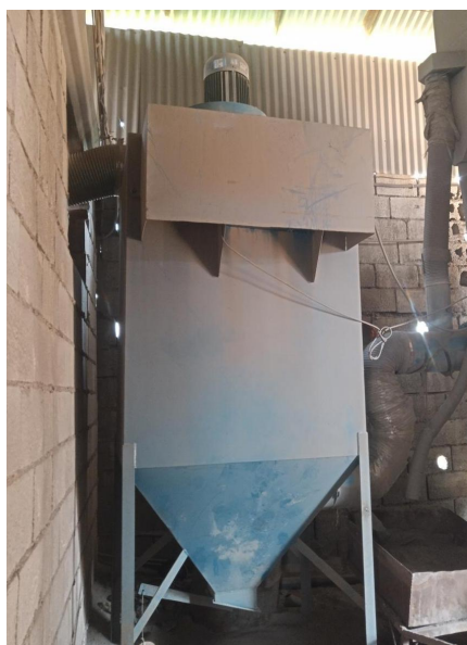
图 3-7 抛丸机除尘器
