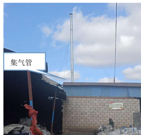
图 3-4 抛丸机排气筒
