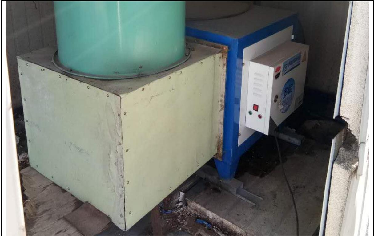
图 4-3 油烟净化器+排气筒
