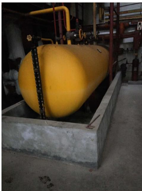
图 10-6 液氨储罐围堰
