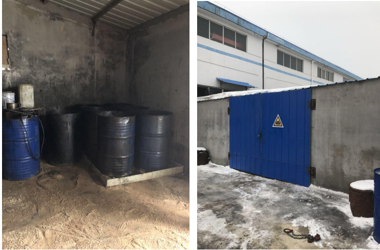
图 10-1 危废贮存间和标识牌
